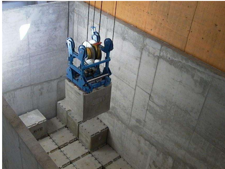
Joonis 2. Radioaktiivsete jäätmete vaheladustuspaik Paldiski objektil
