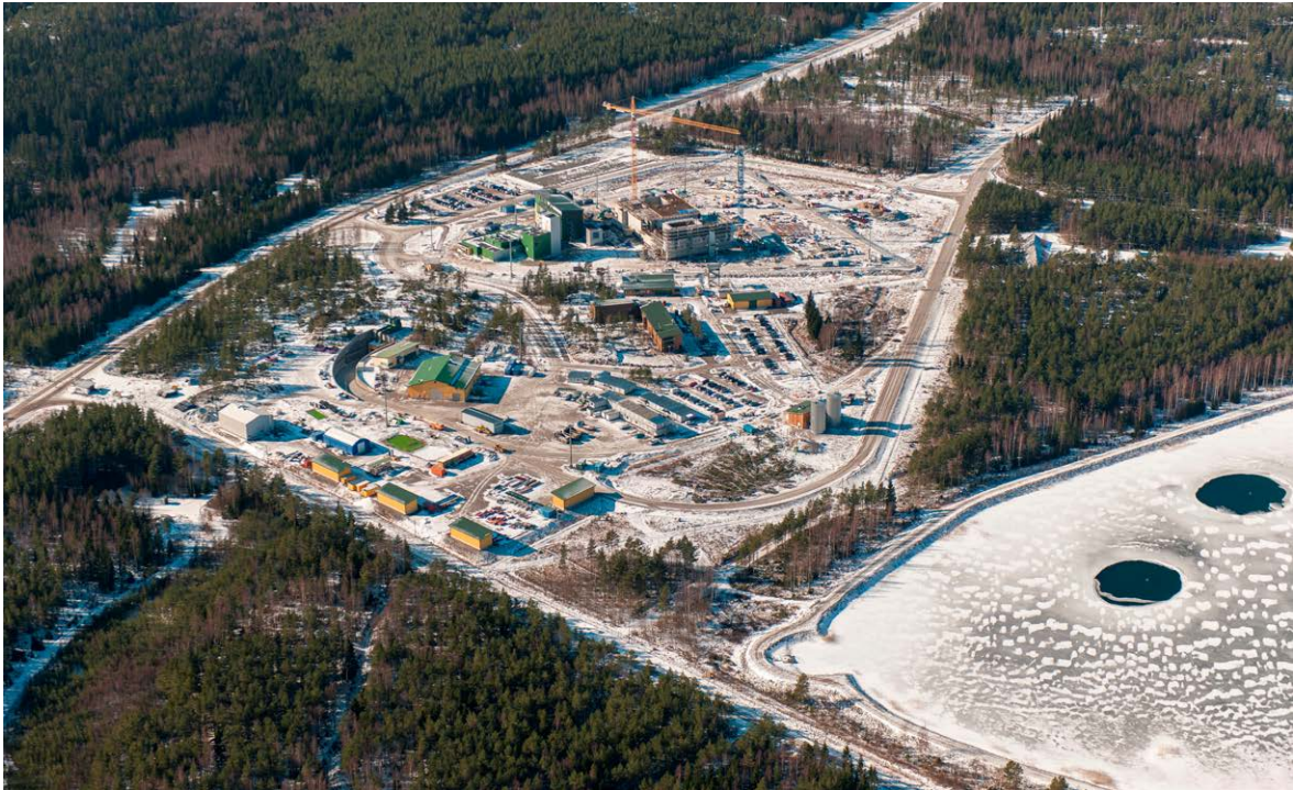
Kuva 2. Talvinen ilmakeku Posivan laitosalueesta. Kuvassa takimmaisena on ilmastointirakennus ja rakenteilla oleva kapselointilaitos. Loppusijoituslaitos sijaitsee noin 430 metriä kapselointilaitoksen alapuolella. Etualalla on Onkalon ajoramppi, Posivan projektitoimistorakennus sekä muita tukirakennuksia Posivan toiminnalle. Olkiluodon ydinvoimalaitosyksiköt sijaitsevat noin kaksi kilometriä länteen Posivan alueesta. Etualalla oleva Korvensuon raakavesialue palvelee Olkiluodon alueen vesitarpeita.
