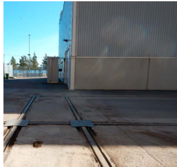
■ Kuva 2. Loviisan ydinvoimalaitoksen KPA-lastausaseman ulkoaluetta (kuva: Capacent).
