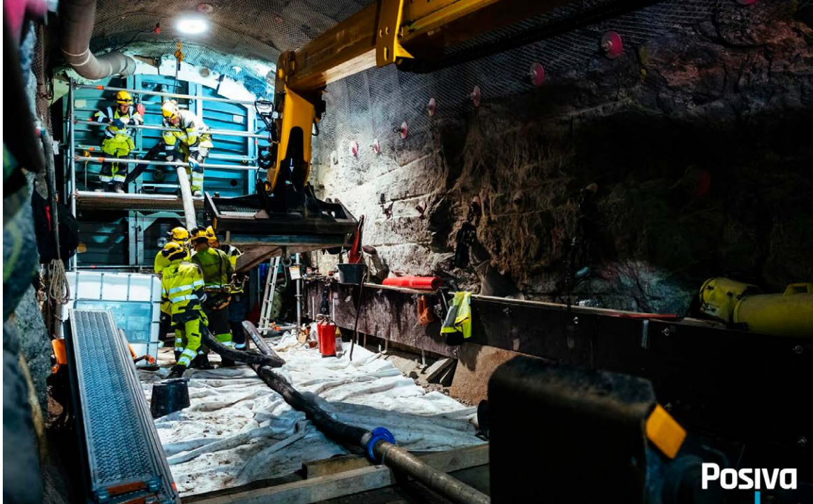
■ Kuva 19. Posiva on tutkinut ja testannut loppusijoitusjärjestelmän rakentamista vuosien ajan Onkalossa.
