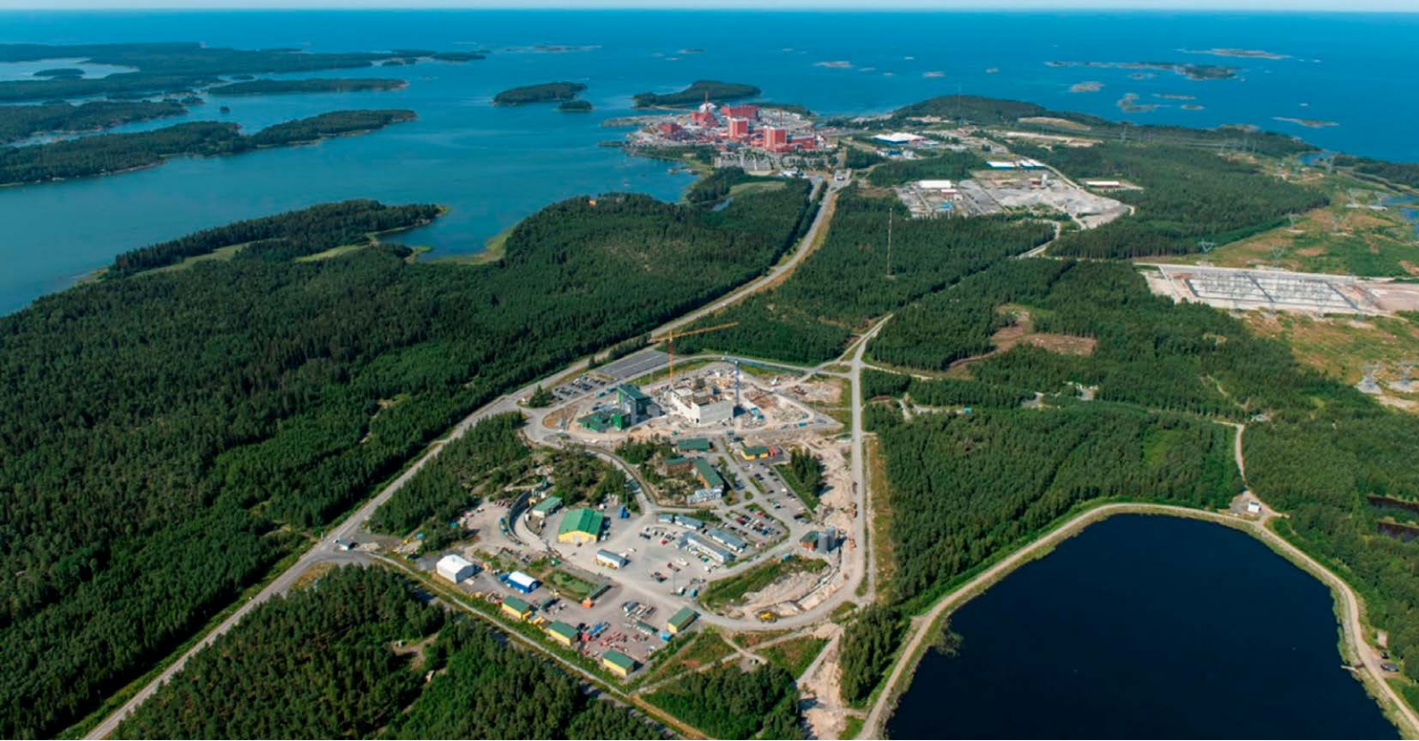
■ Kuva 6-3. Olkiluodon alue kesällä 2021. Kuvan yläreunassa näkyvät TVO:n ydinvoimalaitosyksiköt Olkiluoto 1, 2 ja 3. Kuvassa keskellä näkyvät rakennukset kuuluvat Posivan kapselointi- ja loppusijoituslaitokseen. Rakennusten oikealla puolella on Korvensuon vesiallas.
