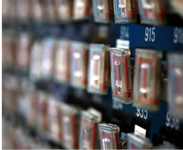
Kuva 5-20. Valvonta-alueella työskentelevien säteilyannoksia tarkkaillaan henkilökohtaisilla termoloistedosimetreillä (TLD), jotka ovat virallisia säteilyannosmittareita.
