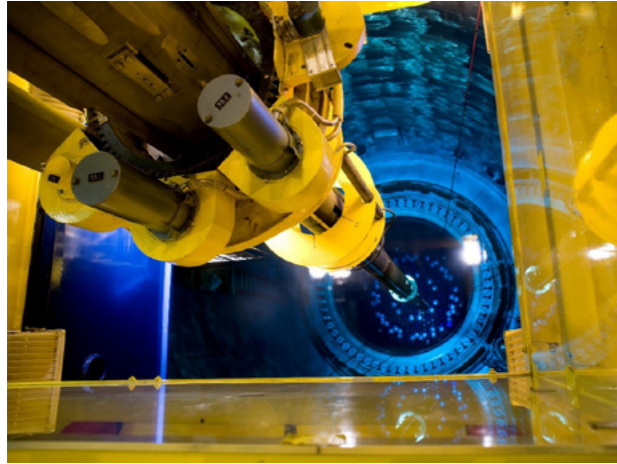
Kuva 5-9. Polttoaineen vaihtolataus. Kuvassa polttoainenippua siirretään latauskoneella reaktoriin.
