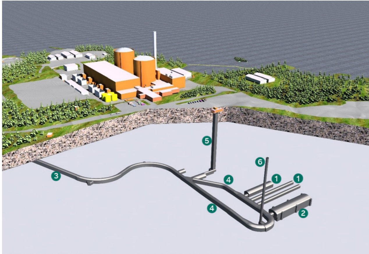
Kuva 5-16. Loviisan voimalaitoksen matala- ja keskiaktiivisen jätteen loppusijoituslaitos nykyisessä laajuudessaan. Layout: Timo Kirkkomäki, Fortum.
