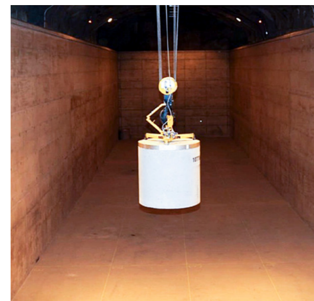
Kuva 5-3. Kiinteät jätteen sisältävän jättepakkauksen siirto kiinteät jätteen tilan betonikaukaloon.
