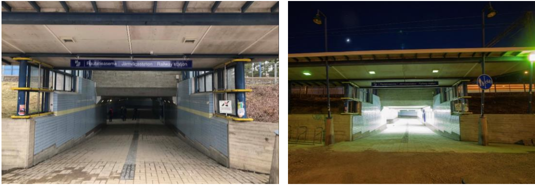
Kuva 68 Alikulkujen valotasot ohjataan luonnonvalon mukaan, koska muutoin päivävalaistus on alimitoitettu ja yövalaistus ylimitoitettu, jopa häikäisevä.
