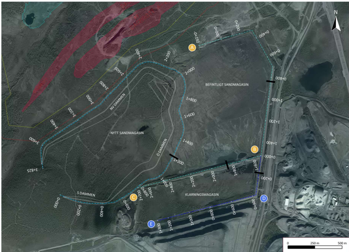
Kuva 8. Yleiskuva, jossa näkyy uusi rikastushiekka-allas, nykyiset rikastushiekka- ja selkeytysaltaat, kaivoksen avolouhos (punaishalla varjostettu alue) sekä ne osat (mustat viivat), joille stabiileettilaskelmat on tehty. Patojaksot on näytetty kirjaimilla A–E.
