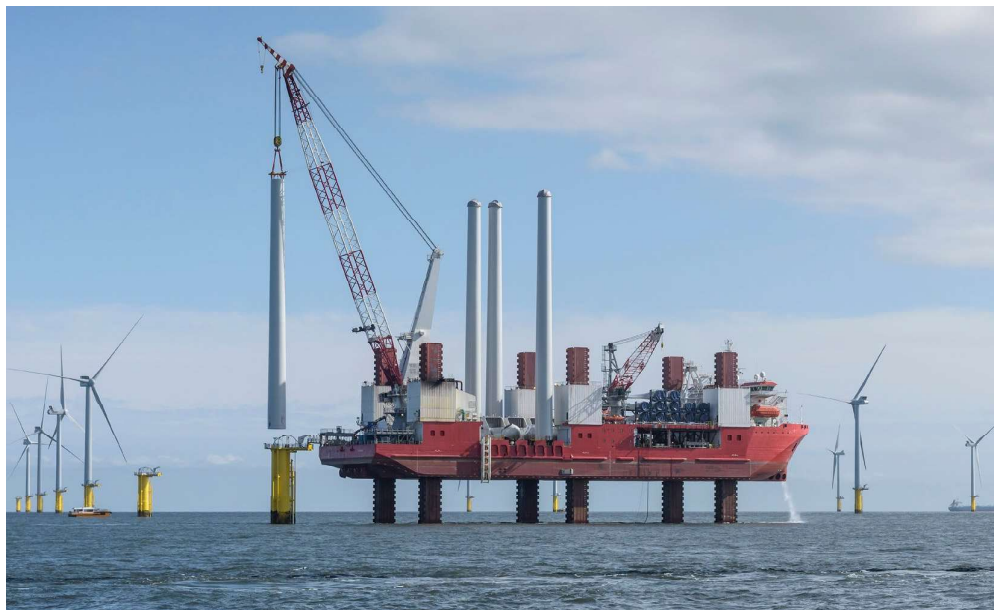
Figur 33. Anläggning av vindkraftverk med jack-up fartyg
