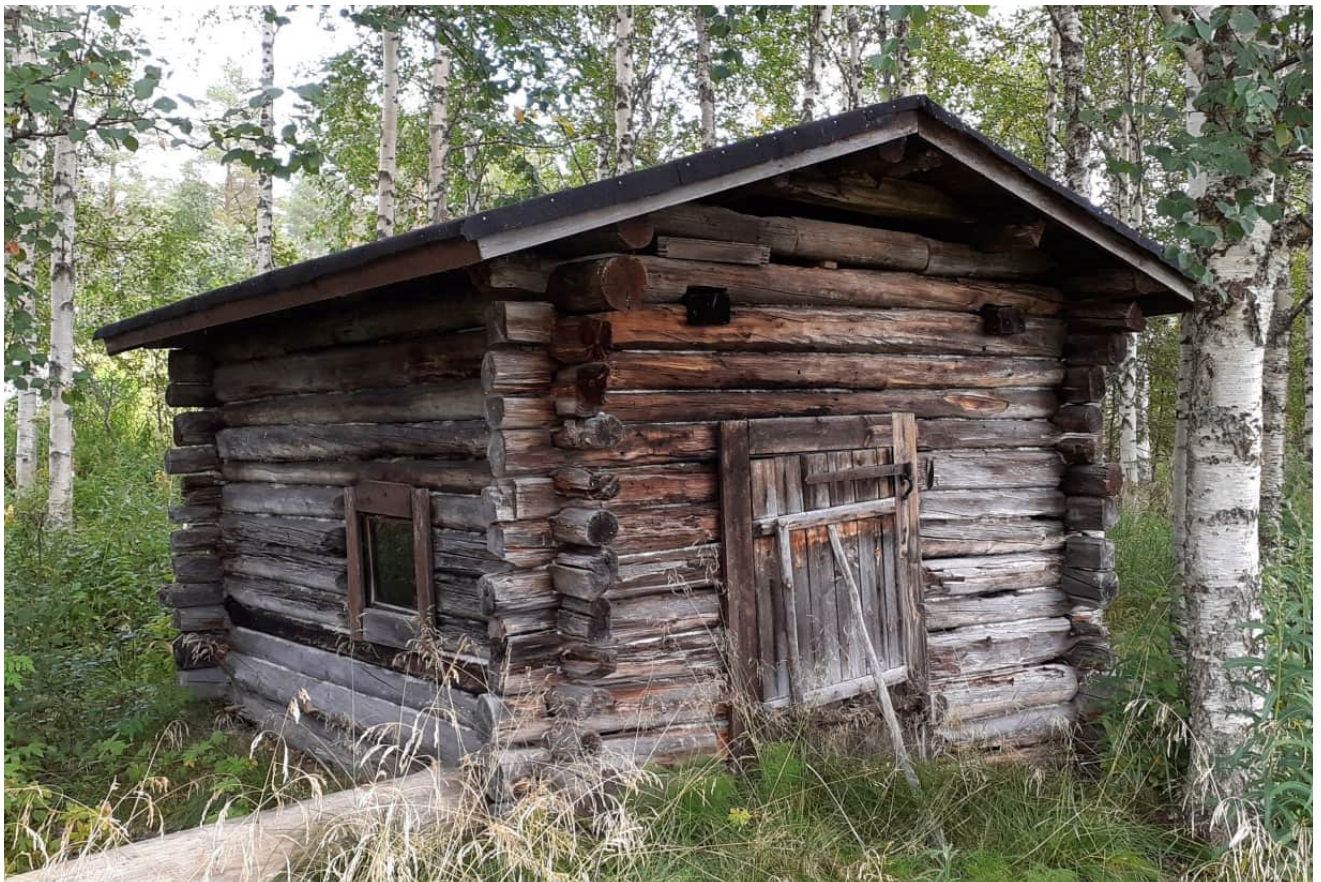
Nykyinen rakennuskanta on yksittäisiä poikkeuksia lukuun ottamatta sotien jälkeen rakennettua. Säästyneisiin poikkeuksiin lukeutuvat kuvan 1920-luvulla rakennettu Ylimäisen savusauna sekä kaksi keskeneräistä hirsikehää ja Lahtelan navetan tiiliseinät (Yrjänheikki. n.d.). Kuva Kari Saariniemi.
