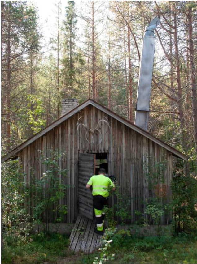
Lemmenkujan varressa sijaitseva kuivuri.
