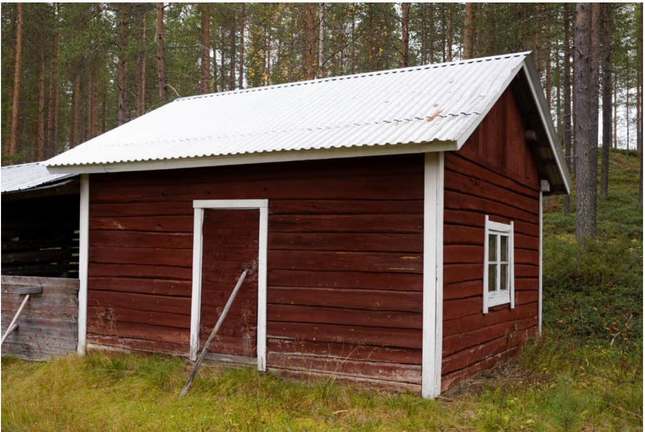
1950-luvun alussa rakennettu, aiemmin tallina toiminut piharakennus on osa osayleiskaavassa suojeltua jälleenrakennusajan pihapiiriä.
