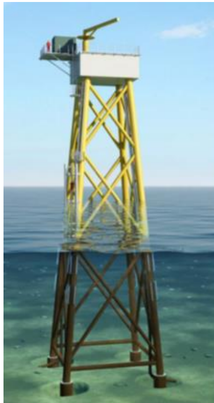
Kuva 3.6. Havainnollistava kuva ristikkoperustuksesta (lähde: Ramboll)
