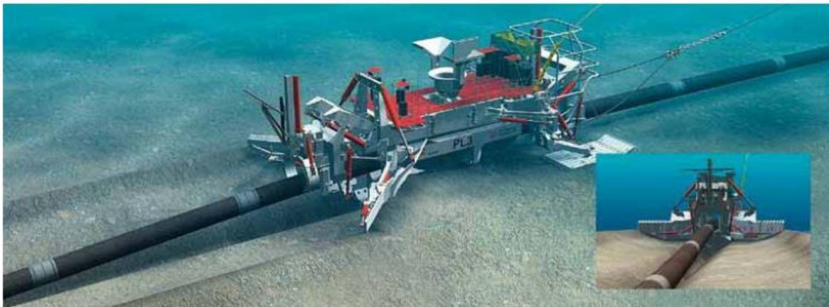
Kuva 7 - Ojan kaivaminen putkiauralla (lähde: Nord Stream, 2011 ).
