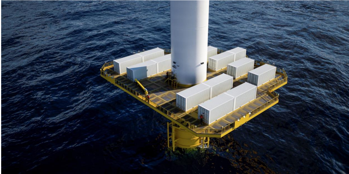
Kuva 6 - Esimerkki turbiinalustan pohjapiirroksista, jossa vedyn tuotanto tapahtuu (Lähde: AquaVentus Förderverein e. V. / Jakob Martens Studios ).
