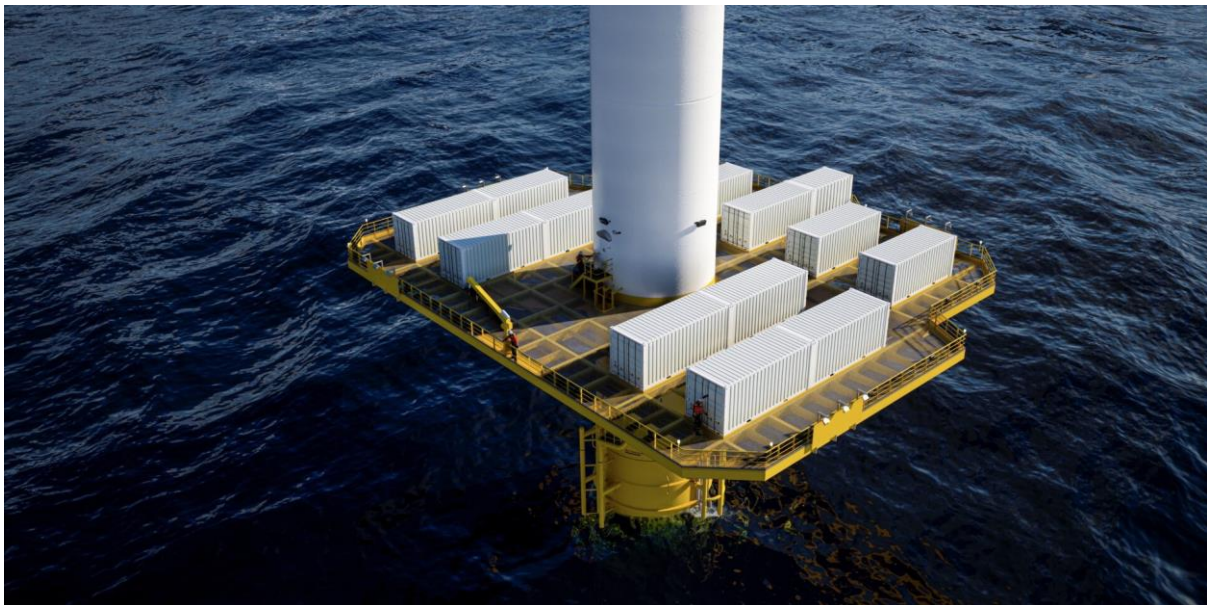
Figur 6 - Exempellayout på en turbinplattform varpå vätgasproduktionen kommer att ske (Källa: AquaVentus Förderverein e. V. / Jakob Martens Studios ).
