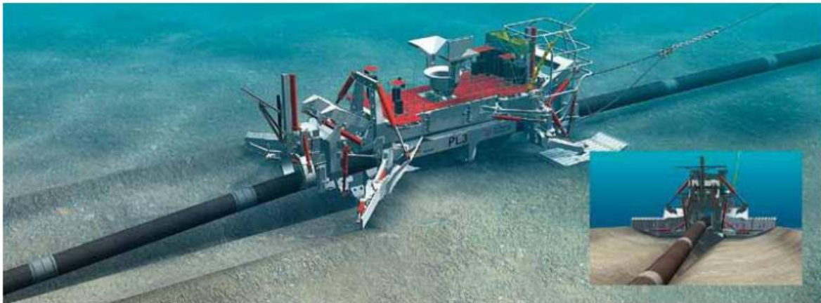
Figur 7 - Dikning med rörledningsplog. (källa: Nord Stream, 2011 ).
