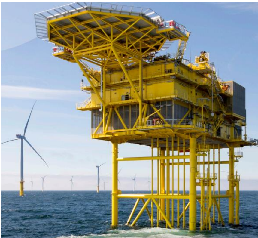
Figur 4 - Exempel på en kompressorplattform. (källa WPD ).
