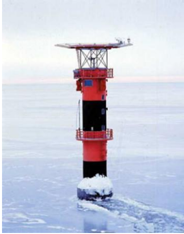
Figur 2.7. Kemi I fyr med en vak av bruten is i isens drifriktning, (foto Finnish Maritime Administration).
