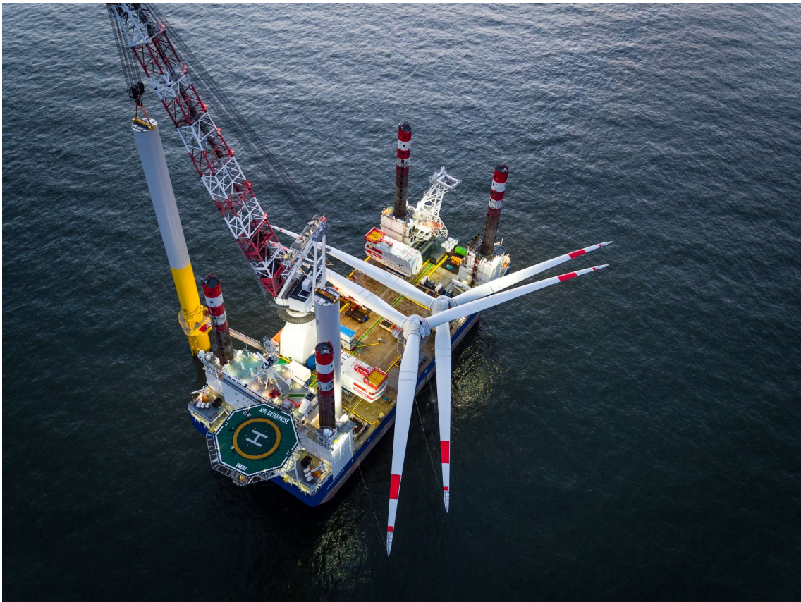
Figur 23 Installation av vindkraftverk. ©Skyborn Renewables
