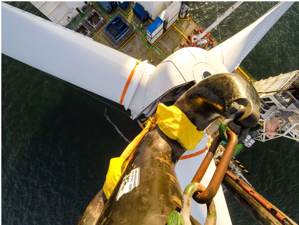
Figur 29 Installation av turbinblad. ©Skyborn Renewables
