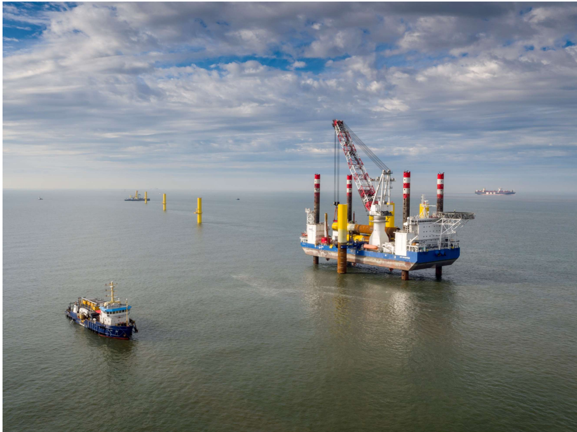
Figur 27 Installation av monopile-fundament ©Skyborn Renewables
