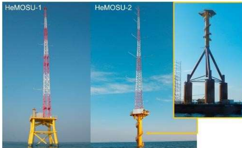
Figur 26 Alternativa fundamenttyper för mätmaster. Källa: Oh, Nam, et.al, 2018
