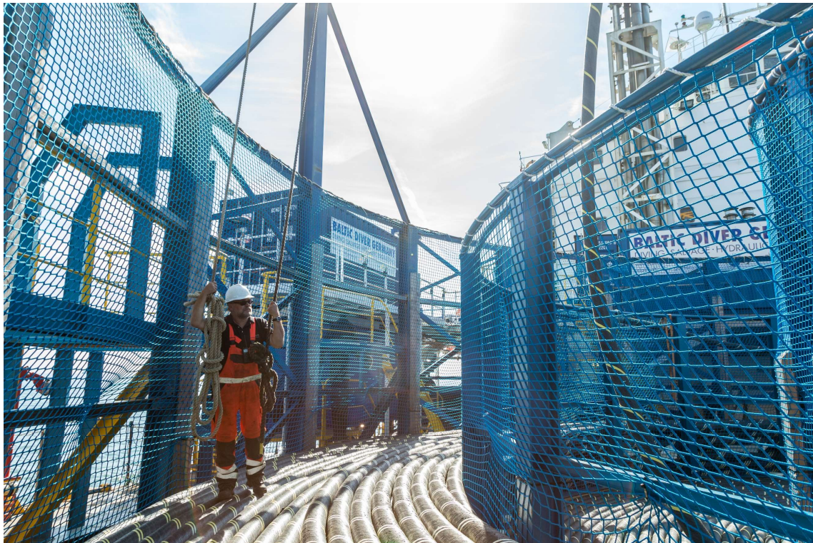
Figur 32 Transport av kabel på kabelinstallationsfartyg. ©Skyborn Renewables
