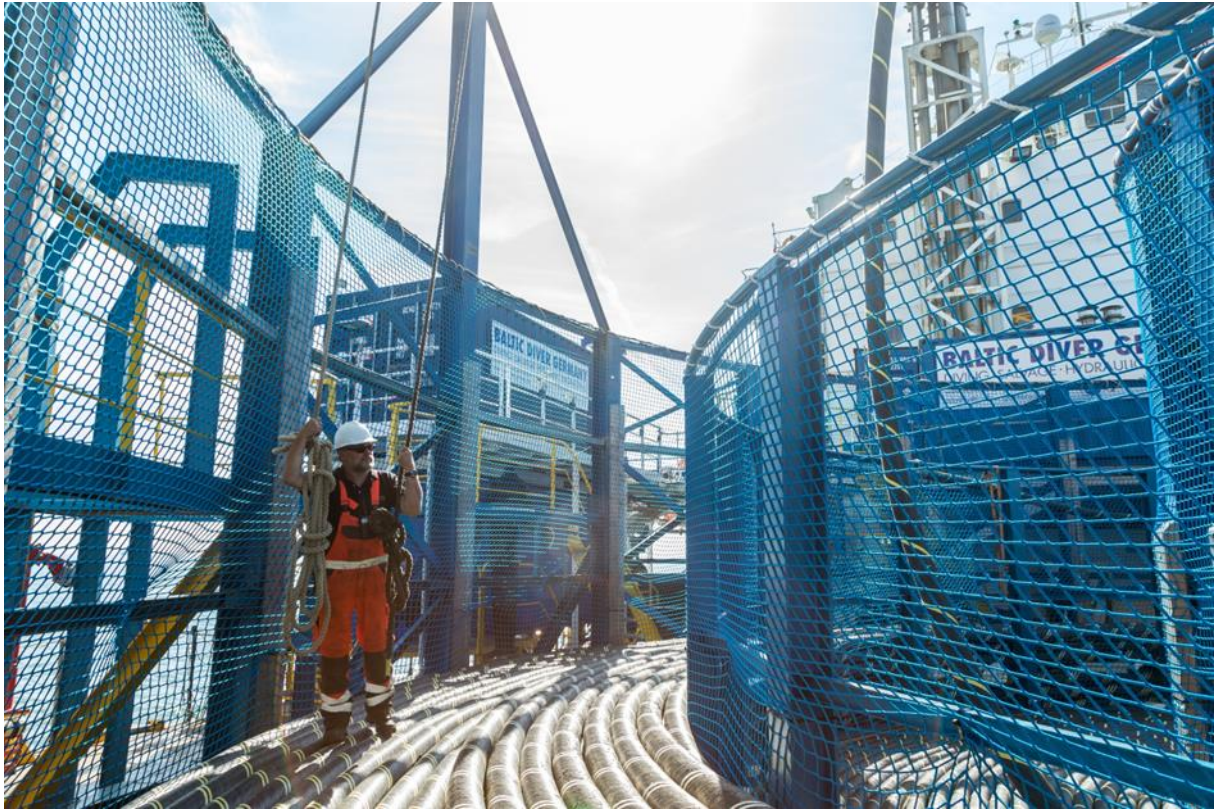
Kuva 32 Kaapelin kuljetus kaapelin asennusaluksella @Skyborn Renewables
