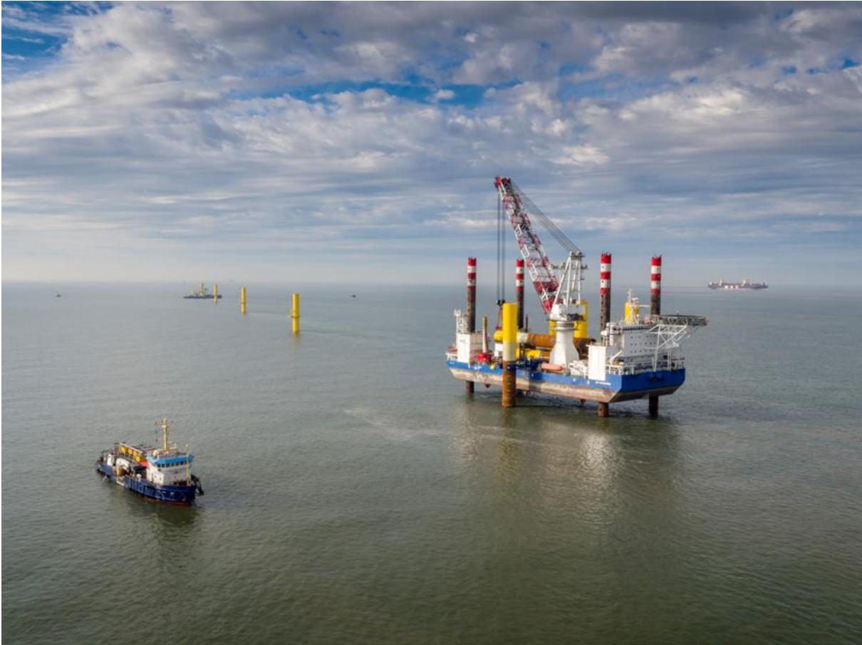
Kuva 27M onopile-perustuksen asennus ©Skyborn Renewables
