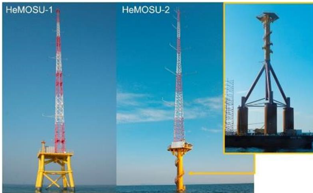
Kuva 26 Vaihtoehtoisia perustustyyppiä metamastoille. Lähde: Oh, Nam, et.al, 2018.
