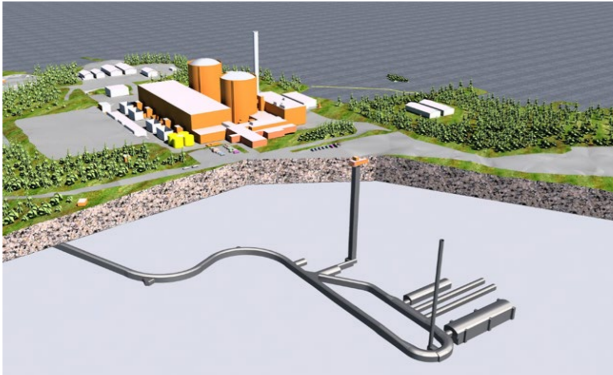
Kuva 3-4. Loviisan matala- ja keskiaktiivisen jätteen loppusijoituslaitos (VLJ-luola) tällä hetkellä. Layout: Timo Kirkkomäki, Fortum.
