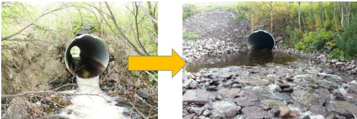
Kuva 7: Kuvassa on esimerkki ihmistoiminnan luomasta vaellusesteestä. Korjauksen jälkeen korkea putous on poistettu ja rummun eteen tehty syvännne. Kalat pääsevät ihmisen rakentaman esteen ohi, ja yläpuolinen vesimuodostuma saavuttaa hyvän ekologisen tilan.
