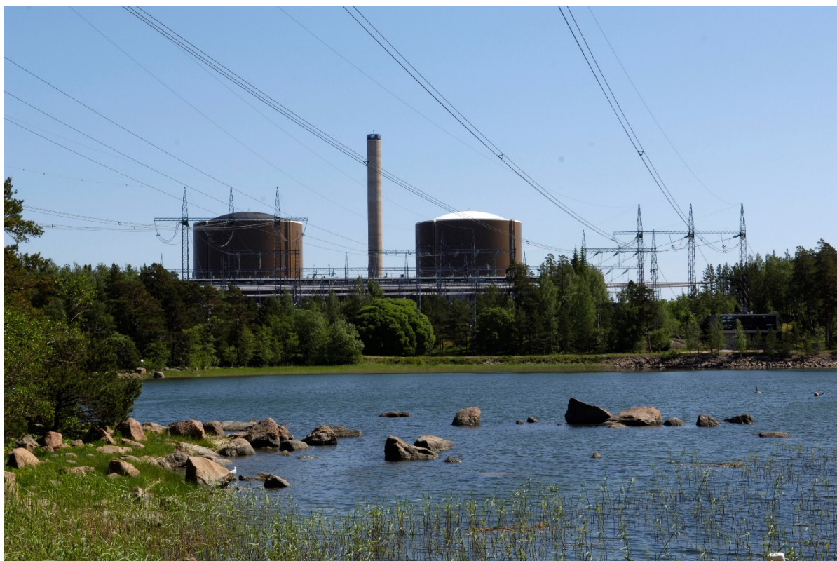
Kuva 3-4. Fortum Power and Heat Oy:n ydinvoimalaitos Loviisan Hästholmenissa. Kuva: Fortum Power and Heat Oy.
