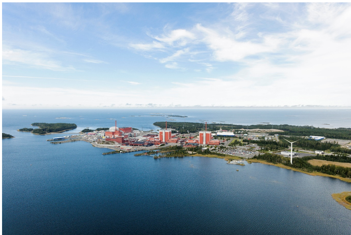
Kuva 3-3. Teollisuuden Voima Oyj:n ydinvoimalaitosalue Eurajoen Olkiluodossa. Kuva: Teollisuuden Voima Oyj.
