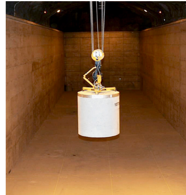
Bild 9-9. Flyttning av förpackning för solidifierat avfall till betongbassäng i slutförvarsanläggningen.
