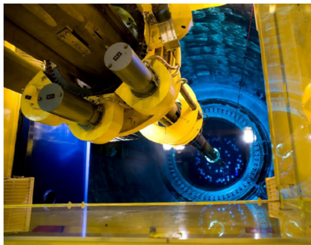
Bild 5-9. Byte av bränsle. På bilden flyttas ett bränsleknippe till reaktorn med en bränslehanteringsmaskin.
