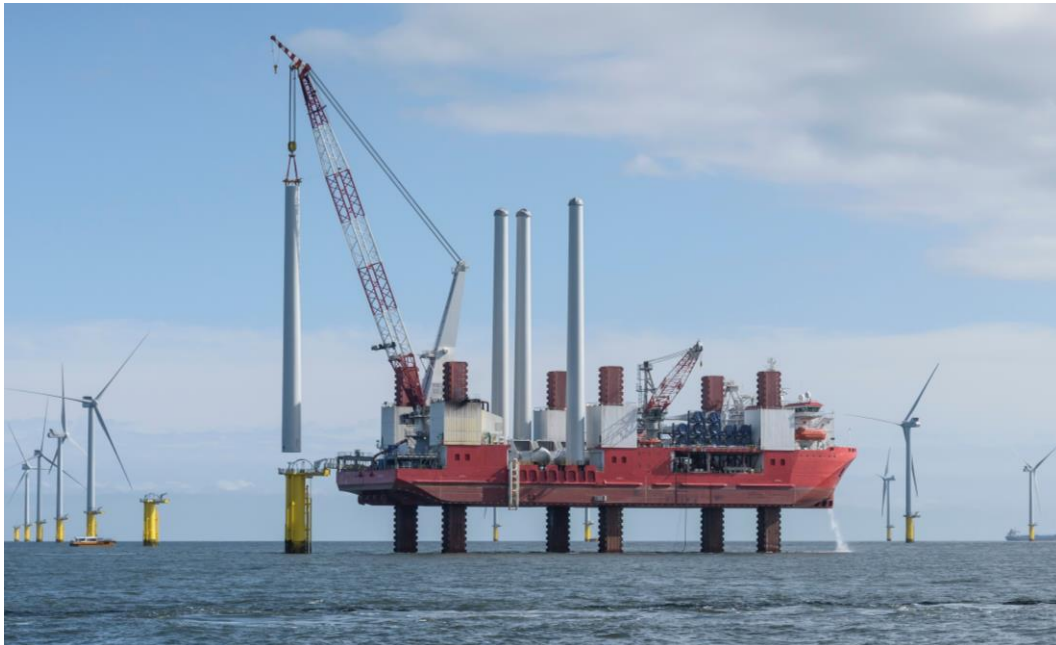
Kuva 33. Tuulivoimalan pystytys jack-up-aluksen avulla.
