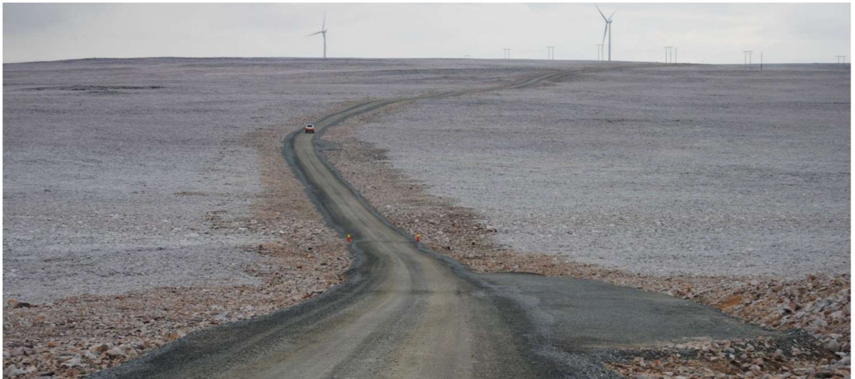
Kuva 4-3: Raggoviddan tuulivoimalaitoksen tieliittymä. Olosuhteet Raggoviddassa ja Davvissa ovat paljolti samanlaiset, joten kuva antaa hyvän käsityksen siitä, miltä Davvin tieliittymä ja sisäiset tiet tulevat näyttämään. Valokuva: Multiconsult Norge AS
