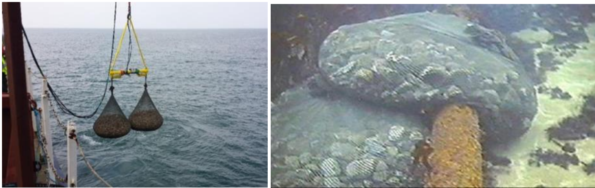
Figur 3.18. Metod att bygga och lägga stennät på kabellinjen (källa: www.bluemont.com.au/erosion/kyowa-rock-filter-bags/offshore-subsea )
