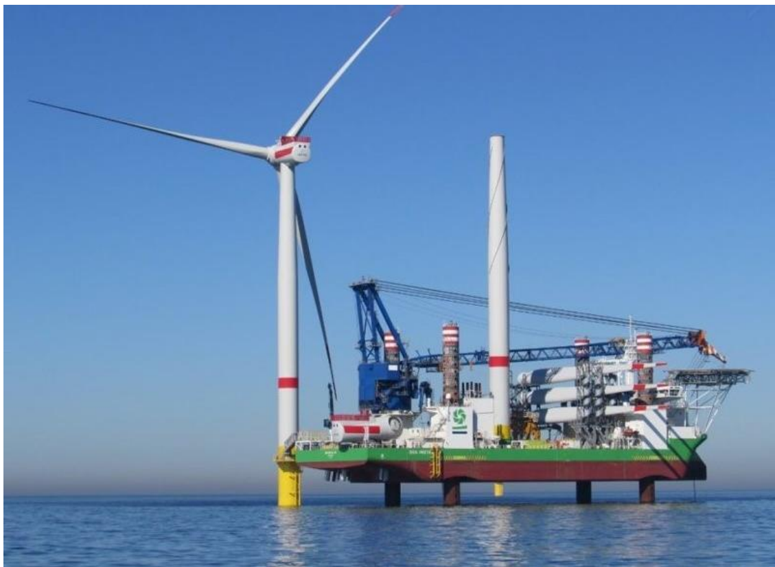
Kuva 94 Tuulivoimaloiden asennus jack-up-tyypin aluksella. Lähde: COWI
