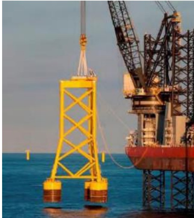
Kuva 3.7. Yleispiirustus perustuksesta - Suction Bucket Jacket foundation [lähde: DNV:n raportti "Merituulipuistojen käytöstäpoistoa koskevien vaatimusten arviointi"]
