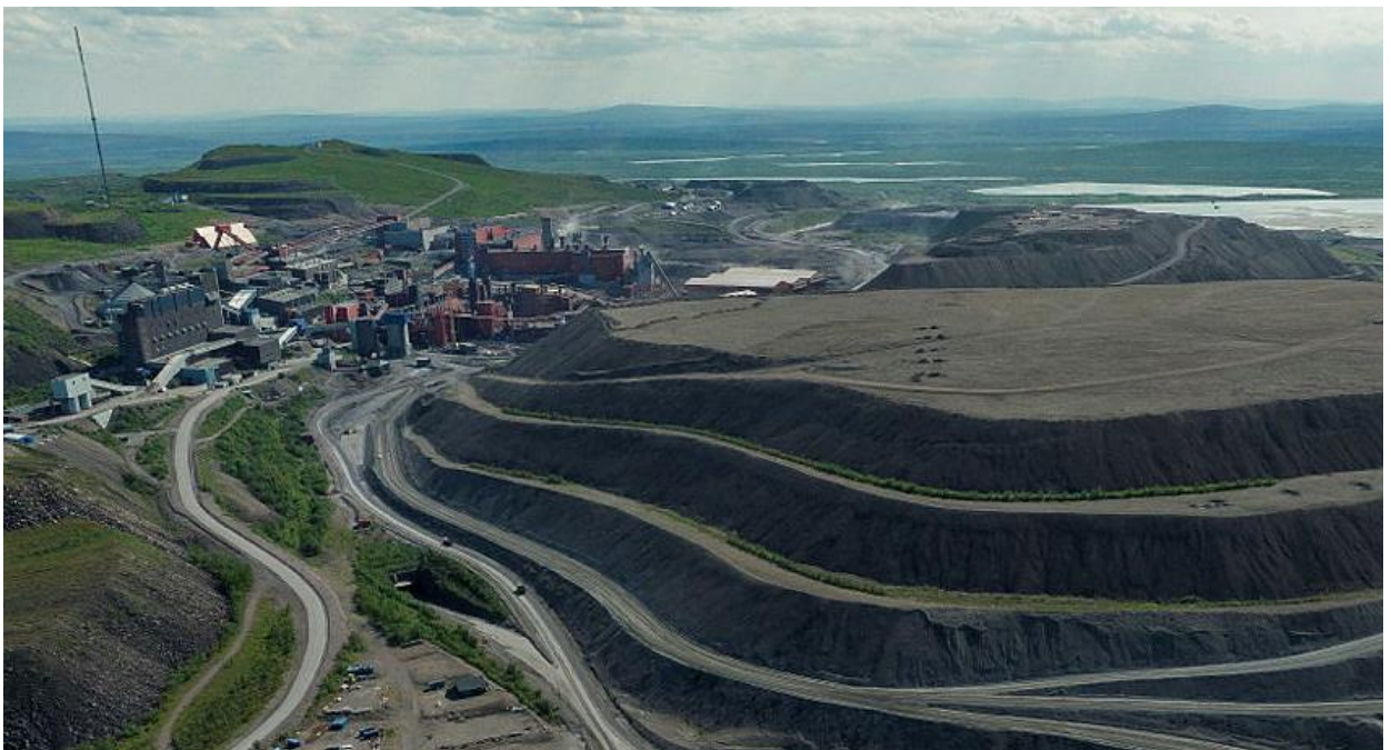
Delar av verksamheten vid berget Kiirunavaara.
